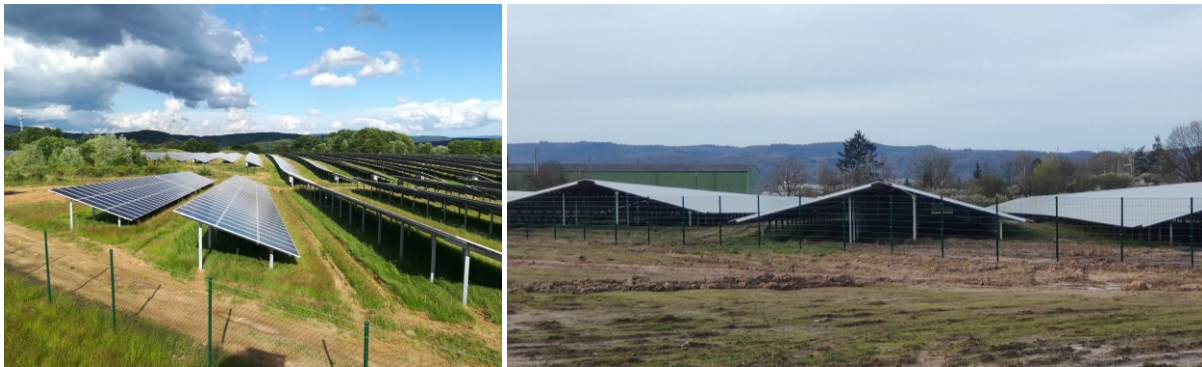
Abb. 1 Konventionelle südausgerichtete PV-FFA (links) und Ost-West-Anlage mit geringen Reihenabständen (rechts).
