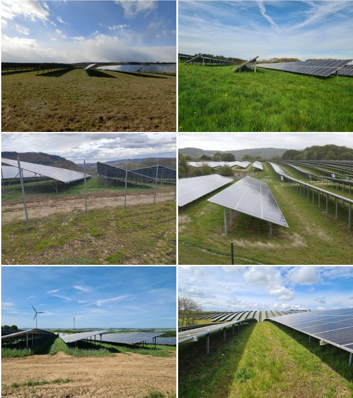
Abb. 3 Beispiele von „südausgerichteten“ PV-FFA mit unterschiedlichen Modultischhöhen, -tiefen, -neigungen und Reihenabständen.
