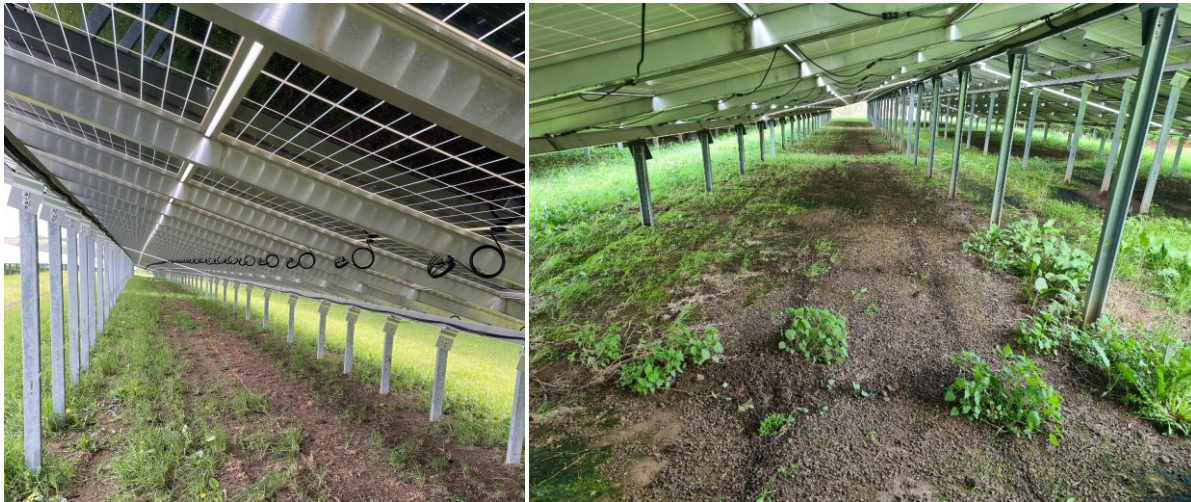
Abb. 5 Beispiele einer reduzierten Vegetationsbedeckung unter Modulen einer südexponierten Anlage (links) und einer Ost-West-Anlage mit geringen Reihenabständen (rechts)
