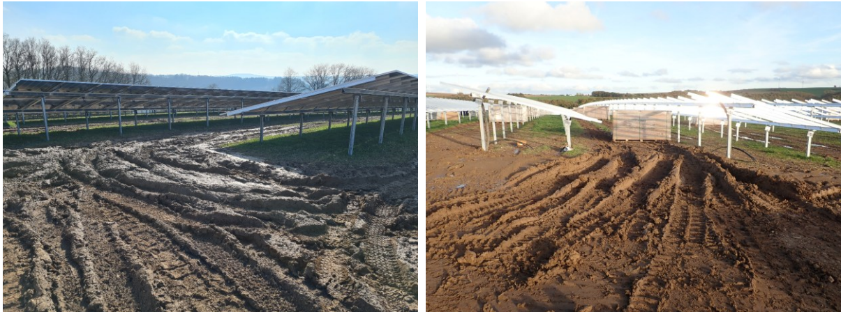
Abb. 4 Zerstörung der Grasnarbe und Bodenverdichtungen durch das großflächige und unkoordinierte Befahren der Fläche bei nasser Witterung
