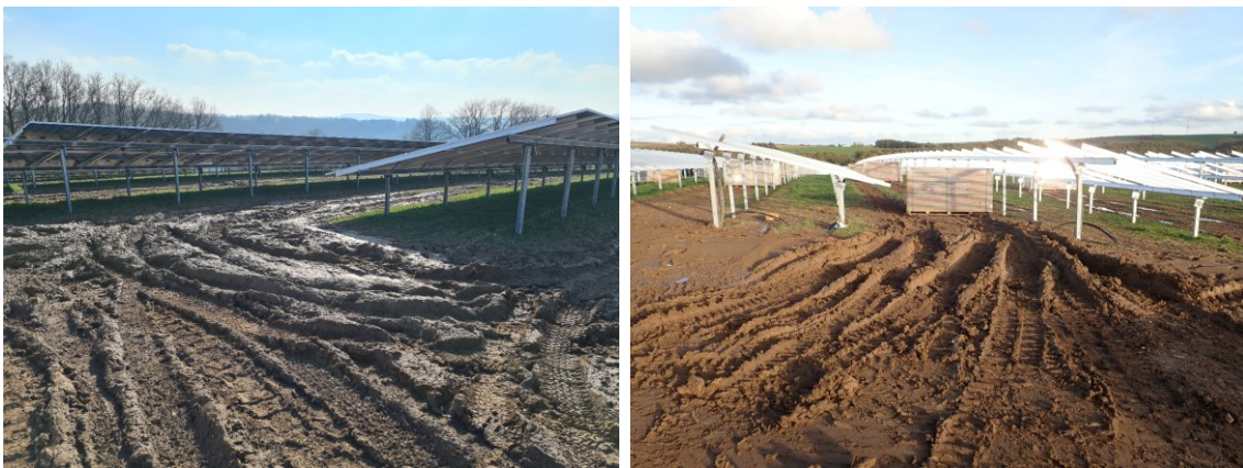
Abb. 3 Zerstörung der Grasnarbe und Bodenverdichtungen durch das großflächige und unkoordinierte Befahren der Fläche bei nasser Witterung
