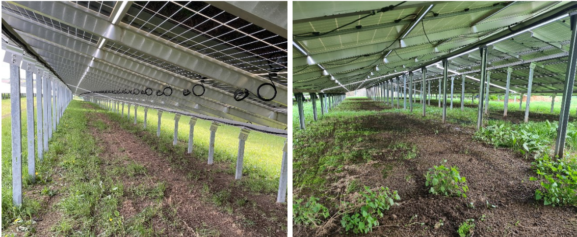
Abb. 4 Blick unter den Modultisch mit spärlicher Vegetationsdecke im Falle einer südexponierten Anlage (links) und einer Ost-West-Anlage mit geringen Reihenabständen (rechts)
